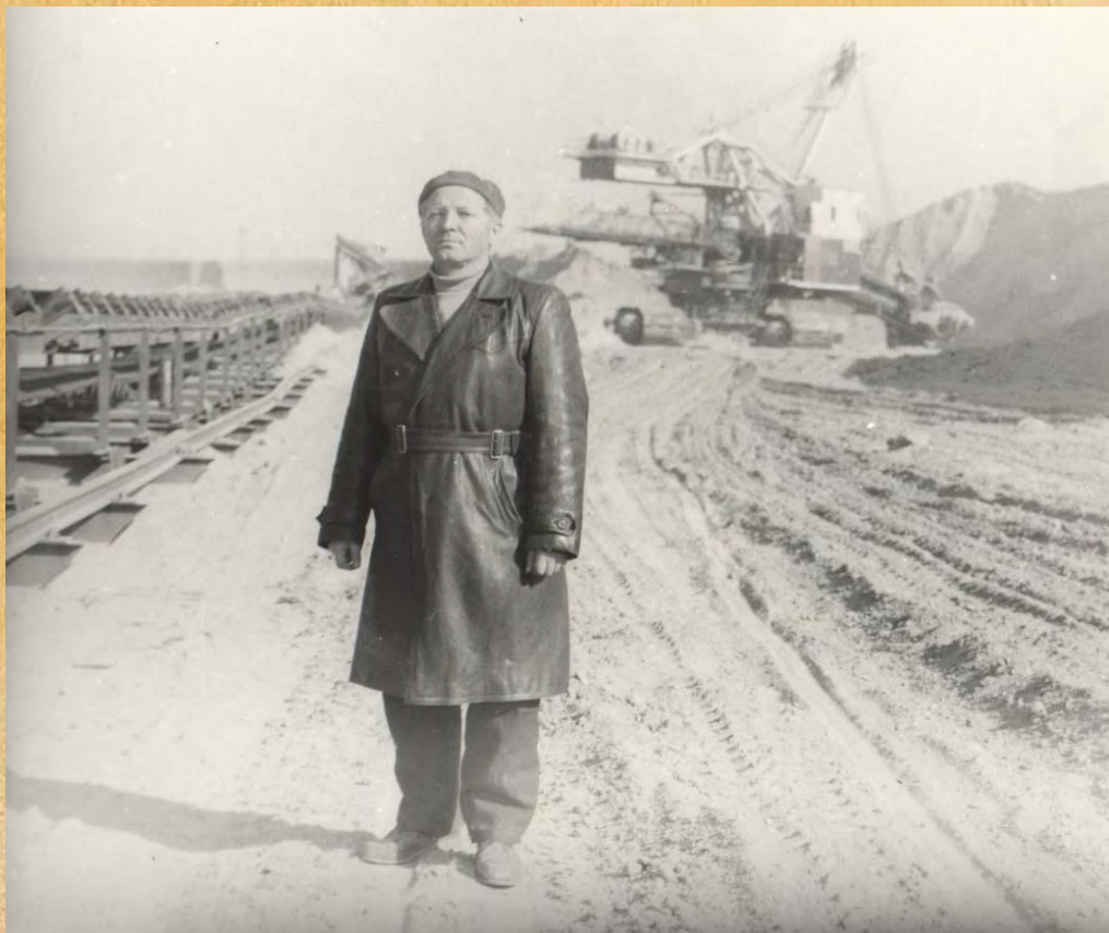
Е.А. Котенко на строительстве горно-металлургического комбината. Навои (Узбекская ССР), 1960 г. Личный архив Е.А. Котенко
